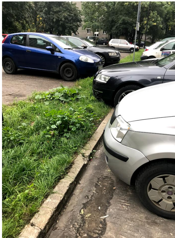
Zdjęcie nr 3 – Fragment istniejącego krawężnika przeznaczonego do wymiany, zieleń do odtworzenia oraz obszar przeznaczonym na miejsca postojowe
