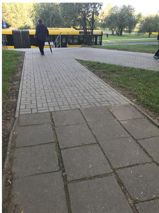
Zdjęcie nr 11 – Istniejący chodnik z płyt betonowych do wymiany wraz z obrzeżami
