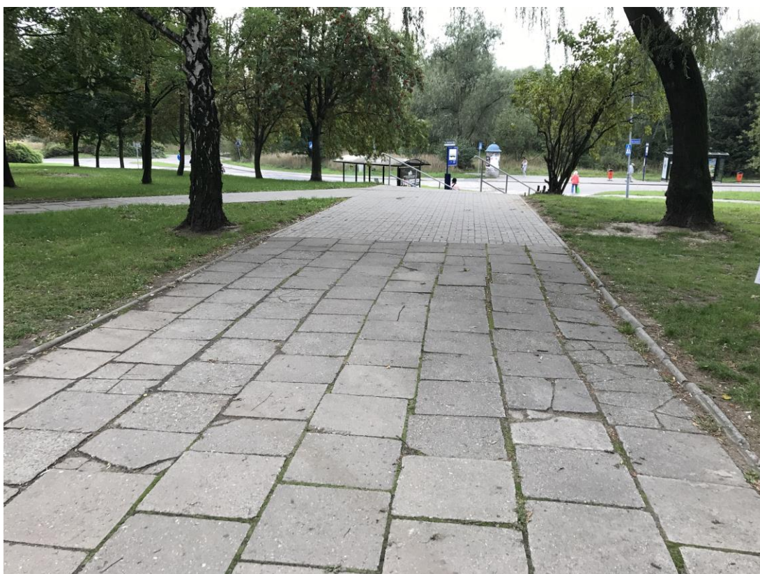
Zdjęcie nr 10 – Istniejący chodnik z płyt betonowych do wymiany, krawężnik do wymiany
