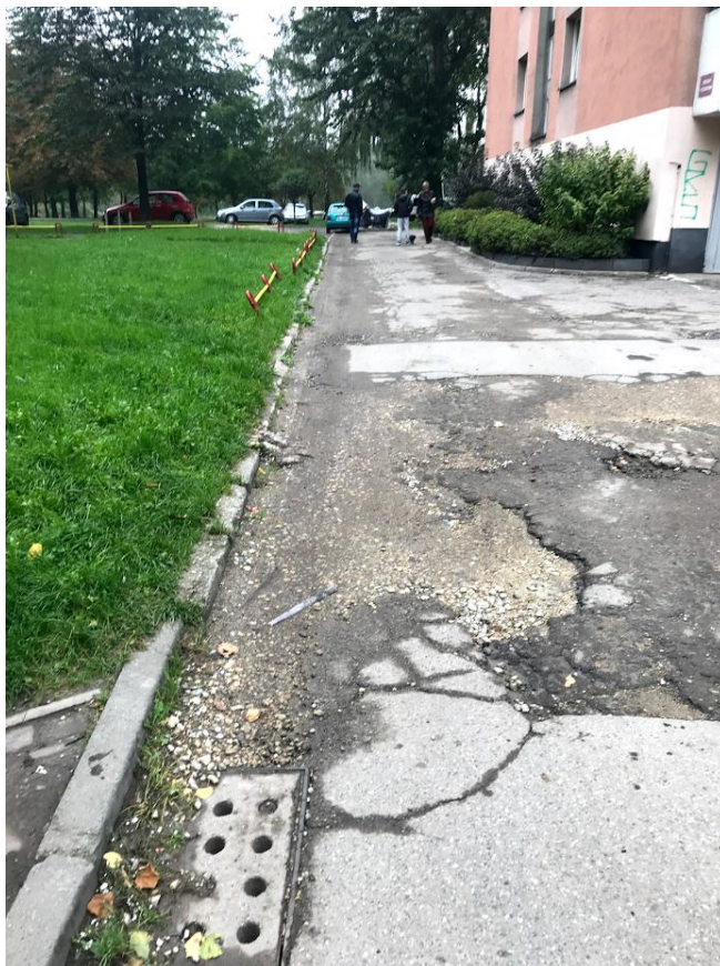
Zdjęcie nr 14 – Istniejący krawężnik do wymiany, nawierzchnia do wymiany, regulacja studzienek
