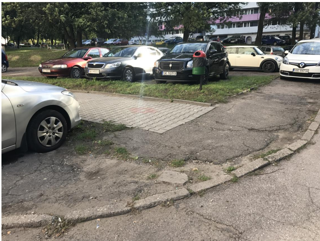
Zdjęcie nr 15 – Istniejący krawężnik do wymiany, wymiana nawierzchni chodnika wraz z krawężnikiem
