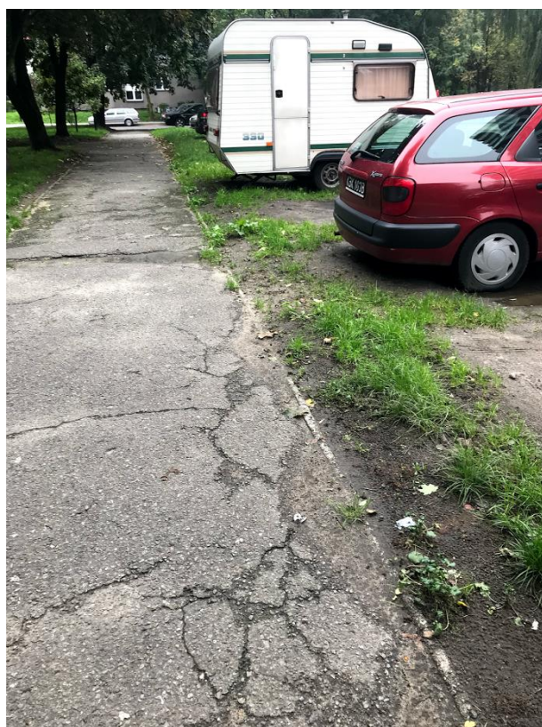
Zdjęcie nr 4 – Istniejący chodnik przeznaczony do wymiany wraz z obrzeżami oraz obszar przeznaczony na miejsca parkingowe
