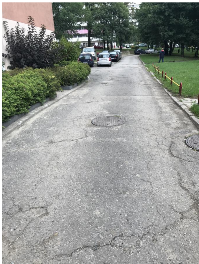
Zdjęcie nr 12 – Nawierzchnia do wymiany, regulacja studzienek
