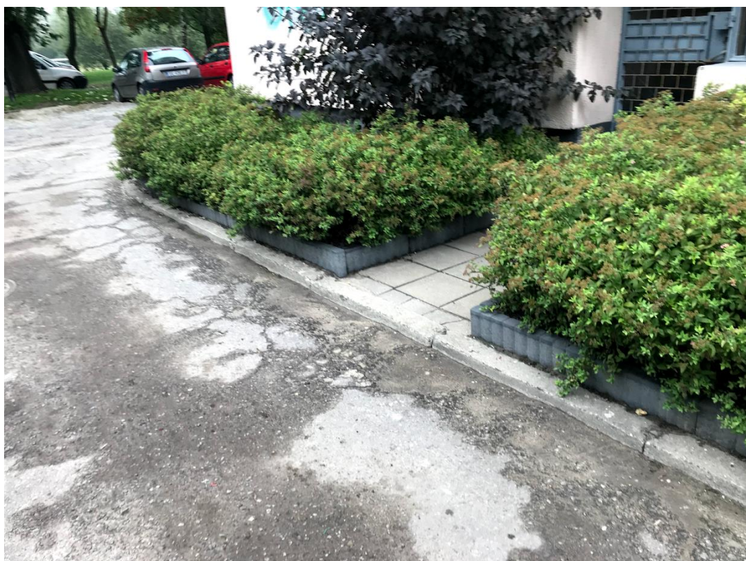
Zdjęcie nr 13 – Istniejący krawężnik do wymiany
