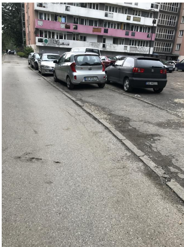
Zdjęcie nr 17 – nawierzchnia chodnika do wymiany wraz z krawężnikiem
