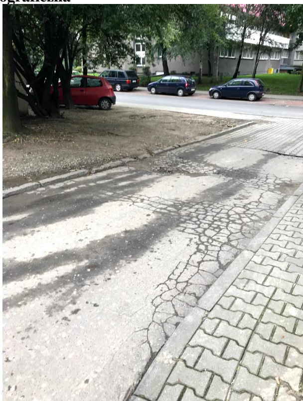
Zdjęcie nr 1 – Wjazd na parking nr 1, asfalt i krawężnik do wymiany, zieleni(trawa) do odtworzenia
